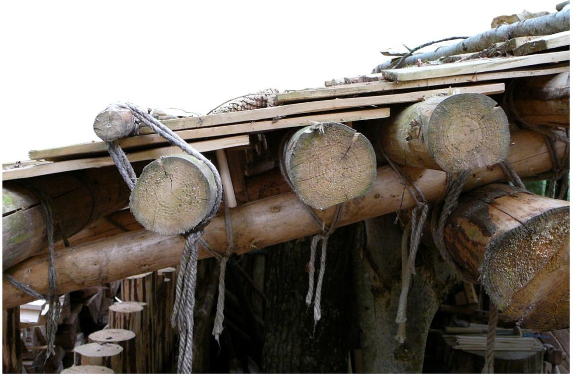
**Abbildung 12 Fichten-Schindeldach mit Kernholz-Holznägel befestigt [vom Campus-Galli-Gelände]**
