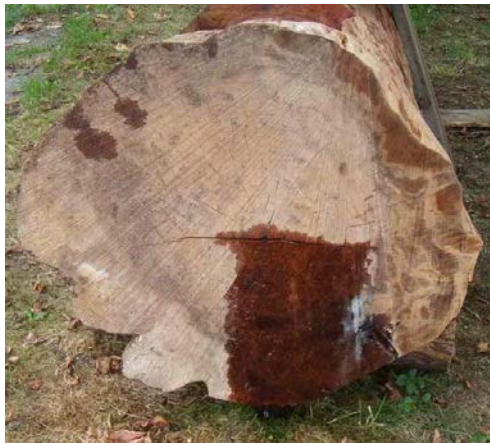
Abbildung 69 Holztrög mit Trocknungsrissen
