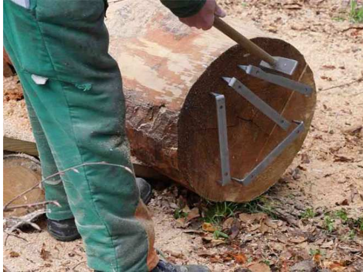
Abbildung 106 Bauklammern in das Stammende schlagen
